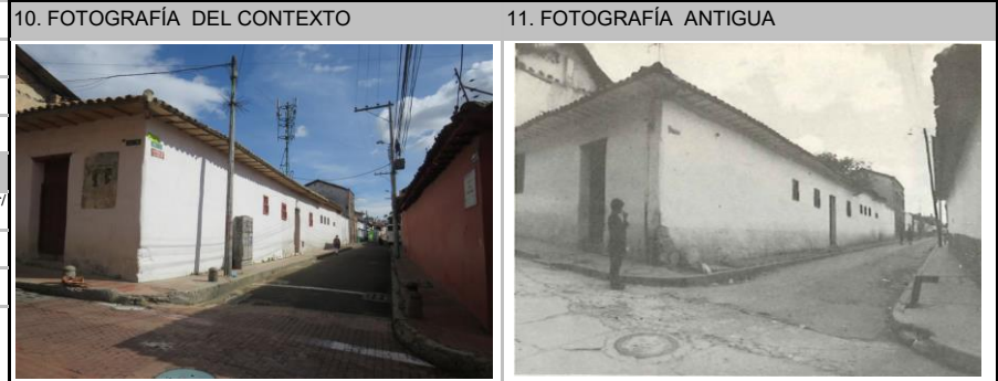
Fuente: Equipo Fotografía PEMP Patrimonio Inmueble
