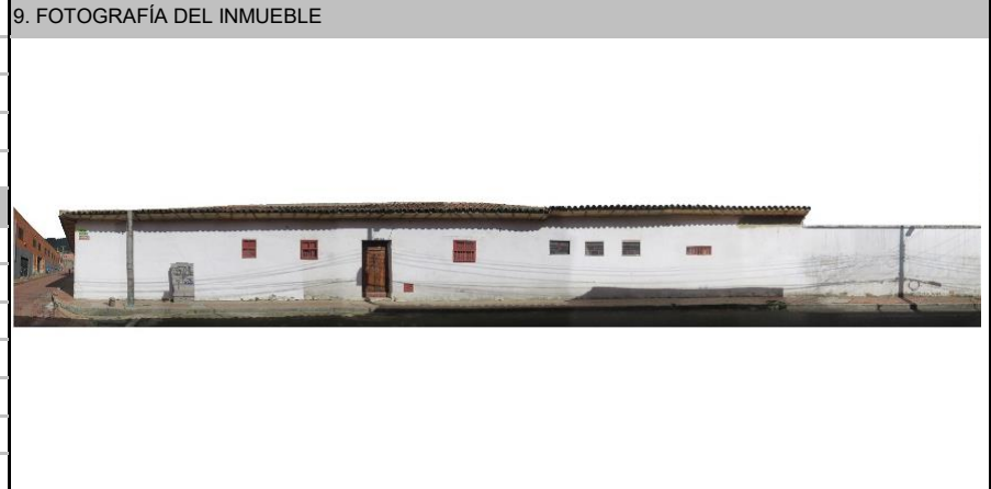
Fuente: Equipo Fotografía PEMP Patrimonio Inmueble
